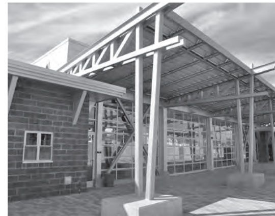
The 5,700-square-foot Green Construction Technology Building. The nearly $3.9 million facility was funded by the school district’s Proposition S bond and state grants. El Edificio Green Construction Technology de 5,700 pies cuadrados. La instalación, con un costo de casi $3.9 millones, fue financiada a través del bono de la Proposición S del distrito escolar y subvenciones estatales.
